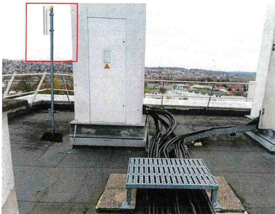
Vue de la terrasse S1 Après travaux
