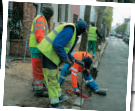
Réfection de trottoirs avenue Carnot
