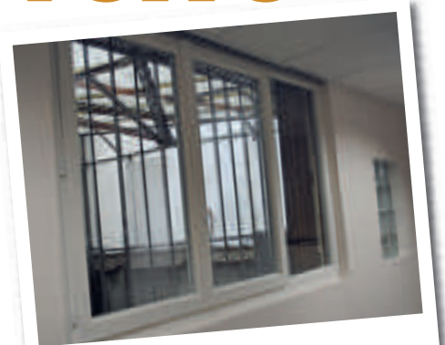
Exemples de réalisations
