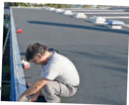
Étanchéité du toit de la piscine
