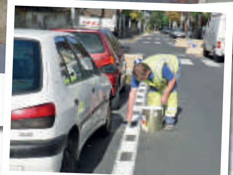
...et marquage au sol
