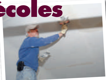
Ecole primaire du Centre : réfection de la peinture de l'escalier
