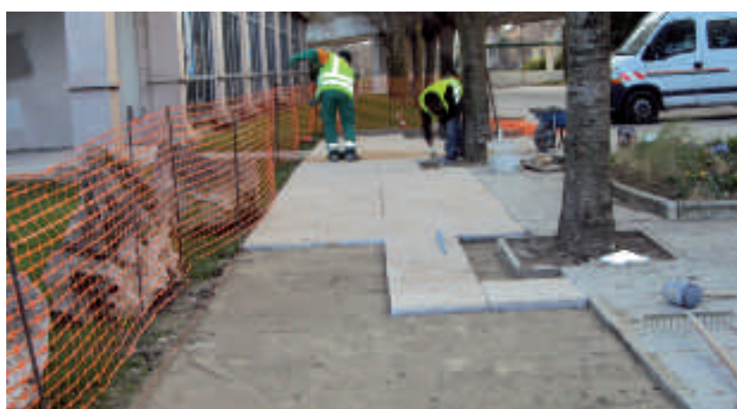
Remise en état du dallage place Montgomery.
