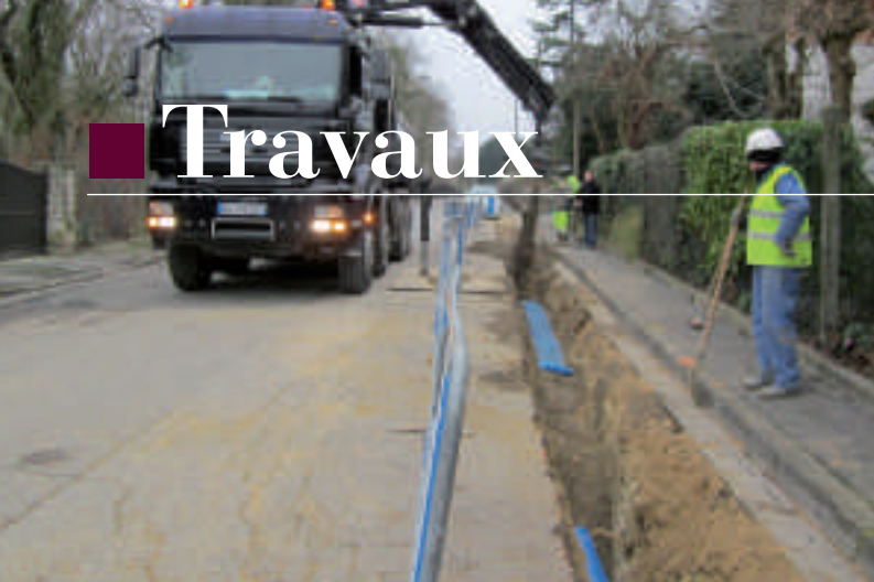
Remplacement de canalisations d'eau potable chemin des Pelouses d'Avron.
