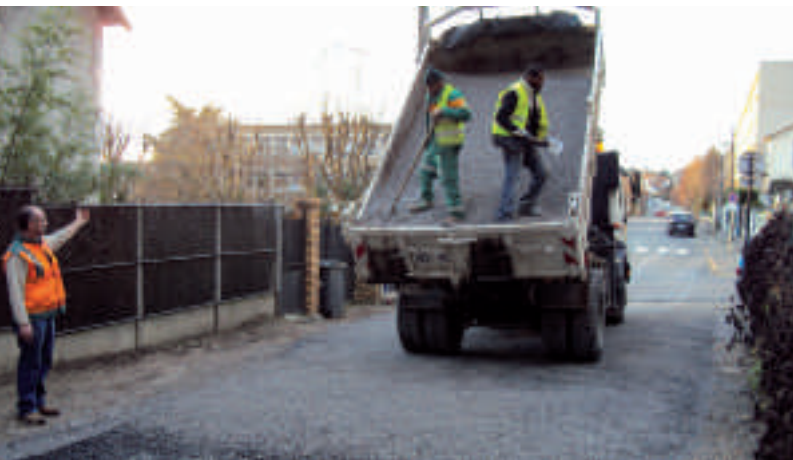
Réfection du gravillonnage chemin du Bel Air.
