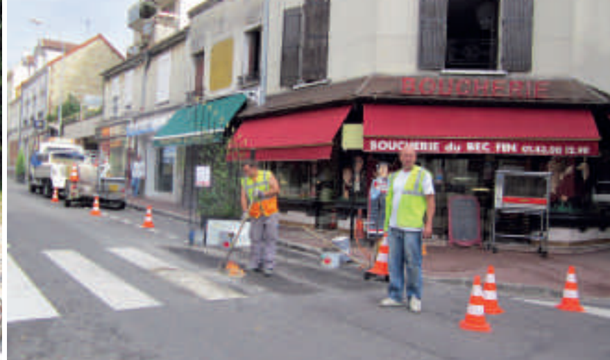
Refection marquage au sol avenue Foch
