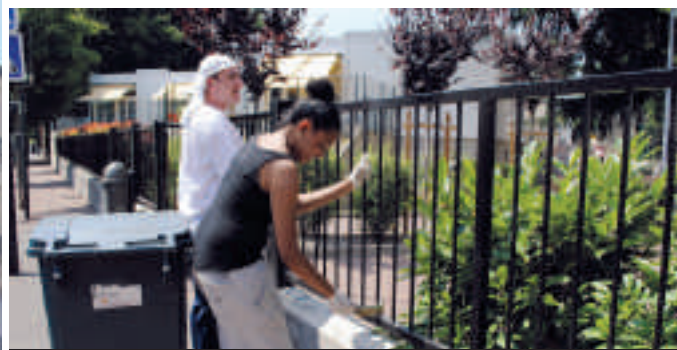
Peinture grille Ecole du Centre
