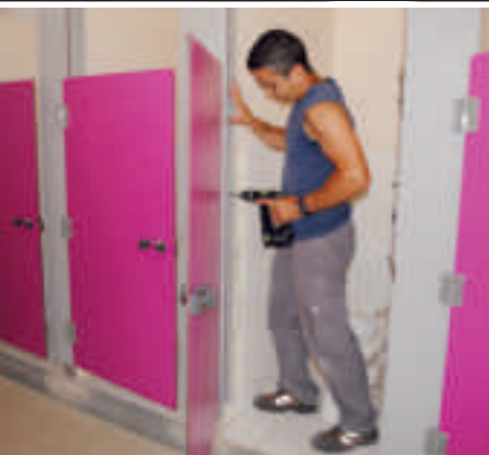
Ecole des Cahouettes remplacement portes sanitaires
