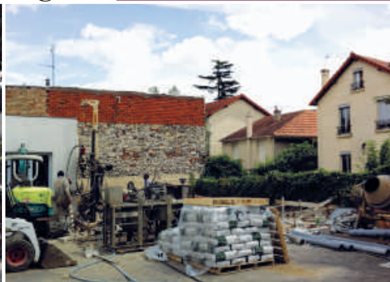
Travaux maternelle Victor Hugo
