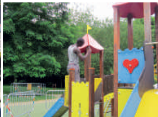
Refection peinture aire de jeux de Grenouilles
