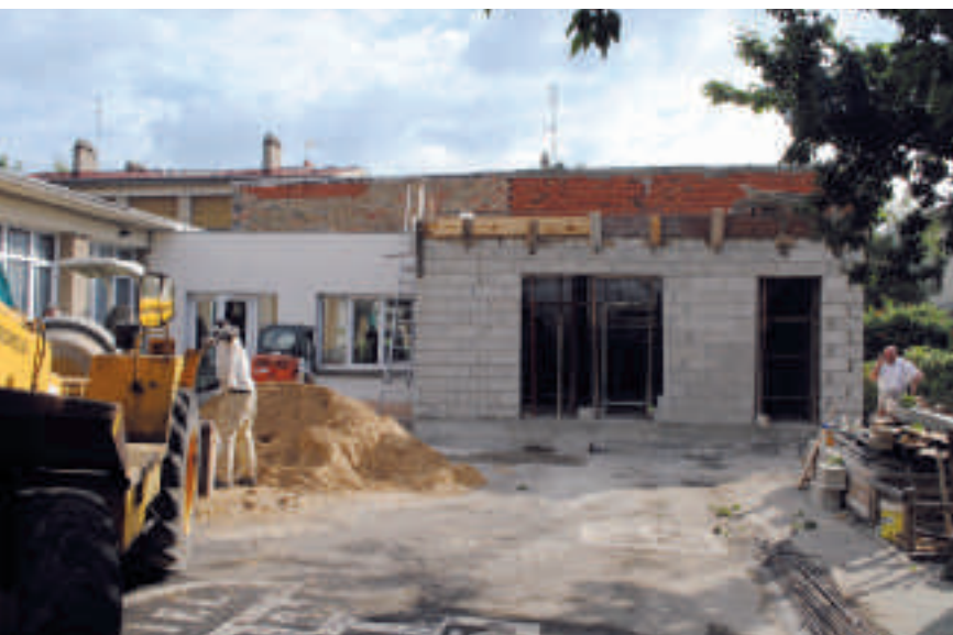
Travaux maternelle Victor Hugo
