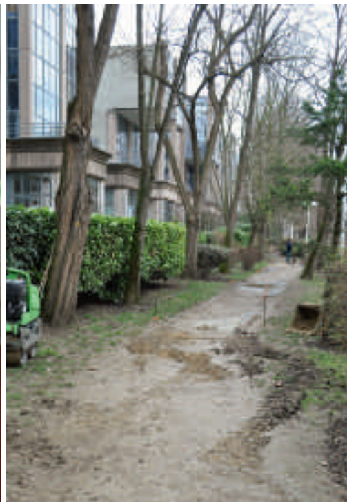
Mi-mars 2013 : Inversion de l'allée piétonne et de la piste cyclable sur l'allée Devambe, mise en place d'un enrobé sur la partie en terre de l'actuel cheminement piéton et plantation d'arbustes divers
