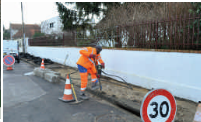
Mi-mars 2013 : Réfection des trottoirs du côté pair sur l'avenue du Nord
