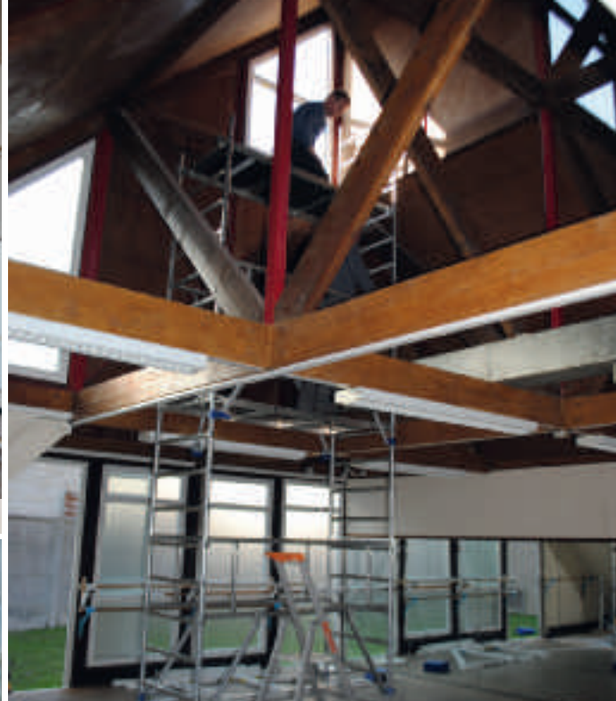
Début Mars 2013 : Pose de fenêtres à la salle Mille Club du stade municipal
