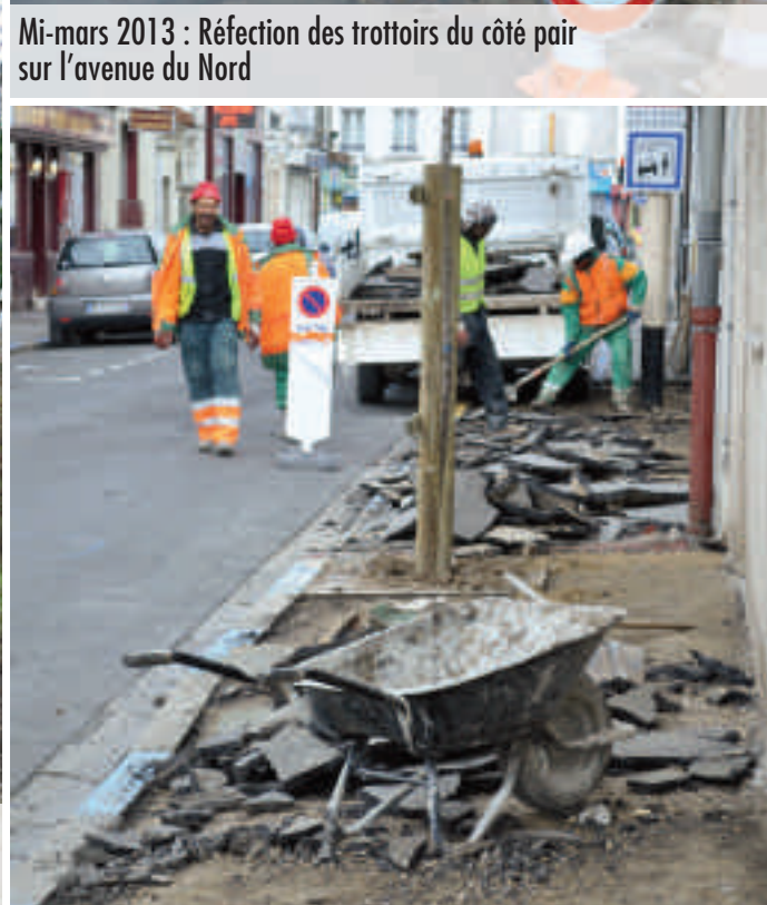
Mi-mars 2013 : Réfection du trottoir avenue Victor Hugo sur le côté impair
