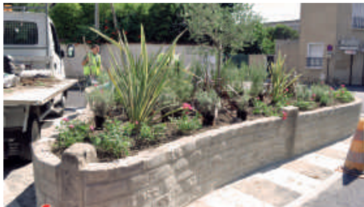
Mi-août - Construction d'une jardinière au carrefour Brossolette - Carnot
