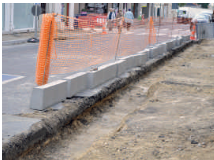
Septembre - Réfection de la chaussée et des trottoirs, rue Clemenceau, entre l'avenue du Maréchal Foch et la rue Gabriel Péri.
