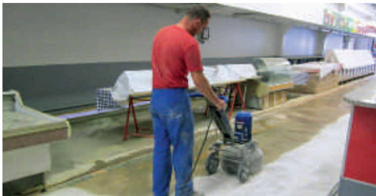
Début août - Réfection du sol du Marché du Centre
