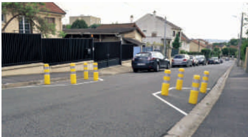
Septembre - Mise en place d'un rétrécissement de chaussée pour ralentir la vitesse, rue des Cahouettes
