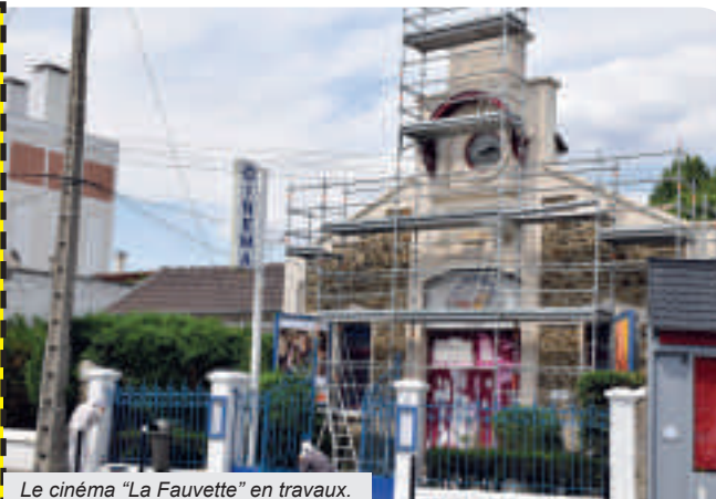
Le cinéma “La Fauvette” en travaux.
