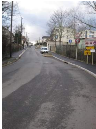
Entrée de ville depuis Villemomble, source : Mairie
