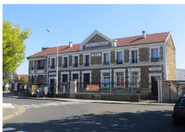
Groupe scolaire, bâtiment en meulière, avenue Daniel Perdrigé Source : Even conseil
