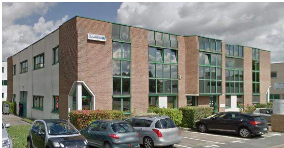
Zone artisanale de la Fontaine du Vaisseau Source : Street View
