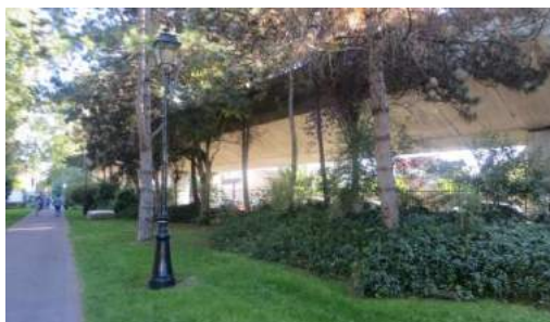
La voie ferrée, début d'intégration par le végétal au niveau de la voie Lamarque
