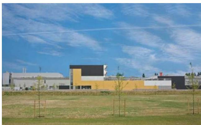
Usine Marne Aval Source : Dossier SIAAP
