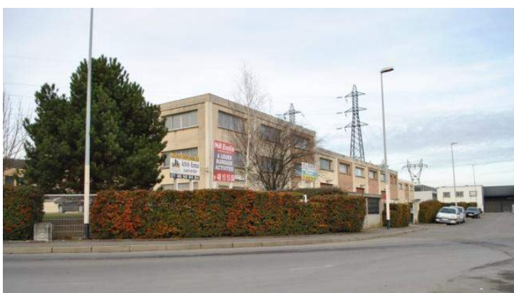
Zone Industrielle des Renouillères Source : Ville de Neuilly-Plaisance
