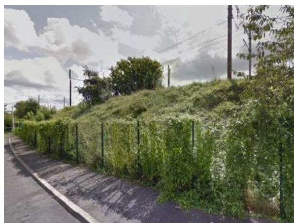
Talus en friches en bordure du RER Source : Even Conseil
