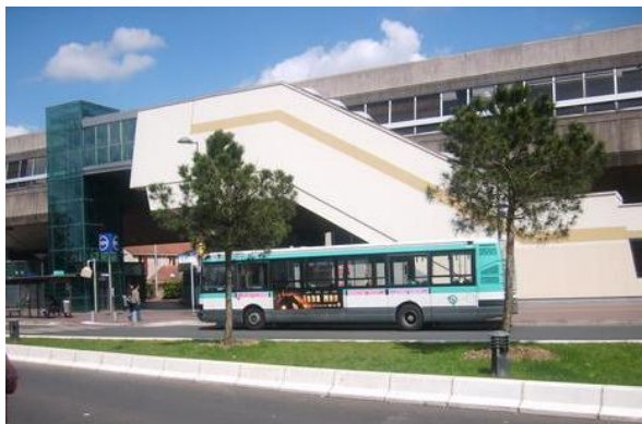
Station de bus et gare RER
